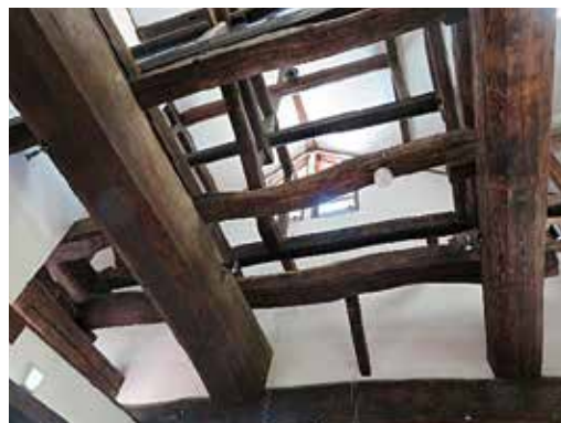
同上（小屋組みの木材が圧巻）
