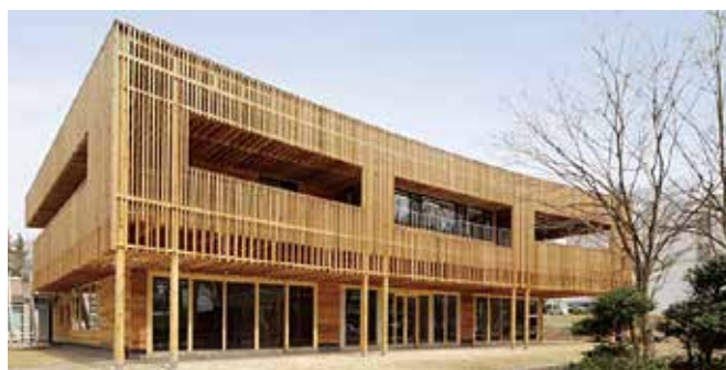
文彦さんが設計した東北大学大学院環境科学研究科エコラボ、川渡農場の山から伐り出したスギ材を使った延べ床面積1,000㎡の木造建築物
