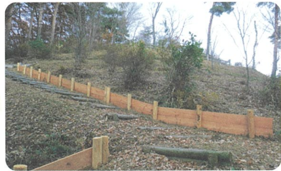
四方山さくら公園森林整備(角田市)
