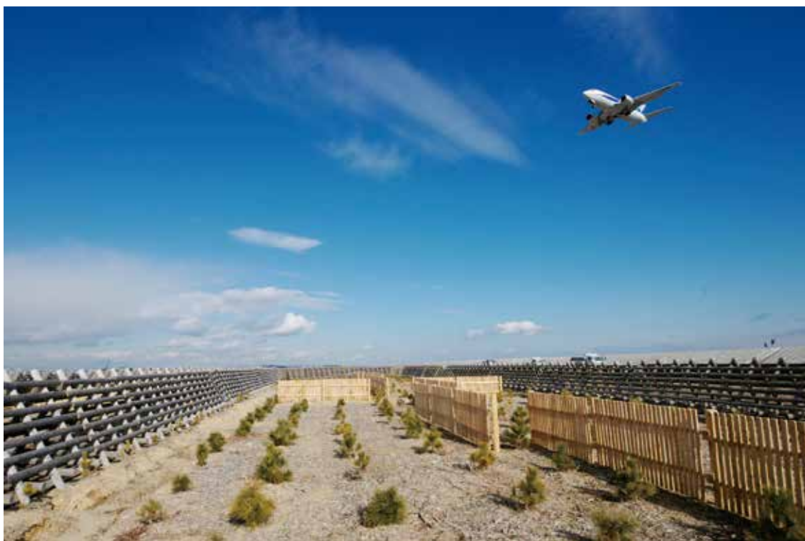
仙台空港に近い名取市東須賀地区の海岸林植栽地（2016年2月7日撮影）
