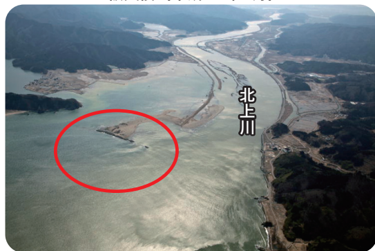
被災後（平成23年4月）
