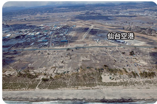
被災後（平成23年3月）
