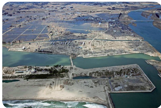
被災後（平成23年3月）
